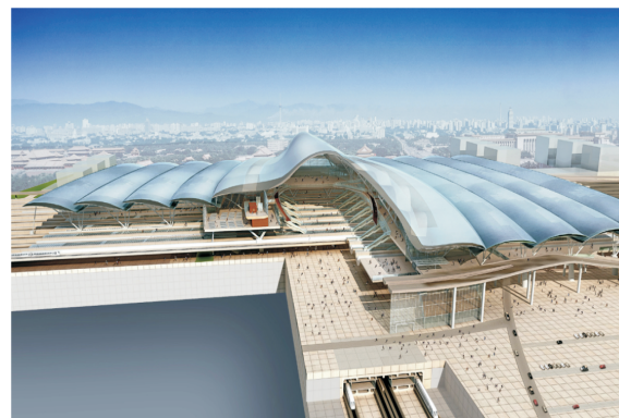
国内外首座“桥建合一”结构形式的铁路站房——武汉火车站
