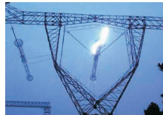
1000kV特高压输电真型杆塔电气特性研究
